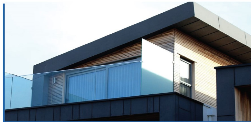
Reabilitação e Construção de Casas
